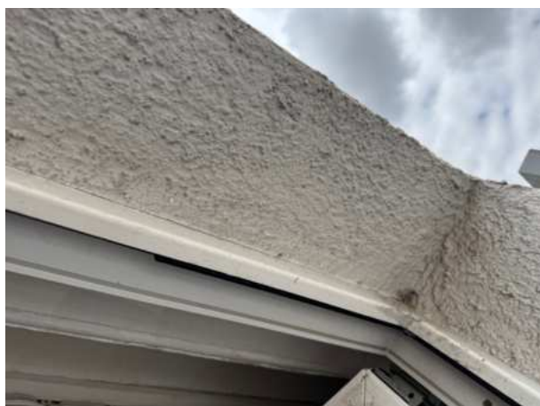
Abb. 14: Rollladenkasten mit wohl zu schmaler Öffnung für Fledermäuse.
